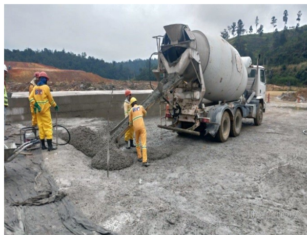
Foto 7: Platô 592, módulo 4, concretagem de regularização. (10/06/2022).
