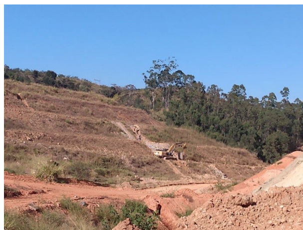
Foto 11: Manutenção no sistema de drenagem do bota fora 2 – margem esquerda (30/06/2022).
