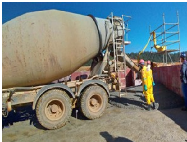
Foto 8: Platô 592, módulo 4, concretagem de regularização (28/07/2022).
