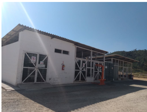
Foto 3: Situação atual das Estruturas no Canteiro operacional (31/08/2022)
