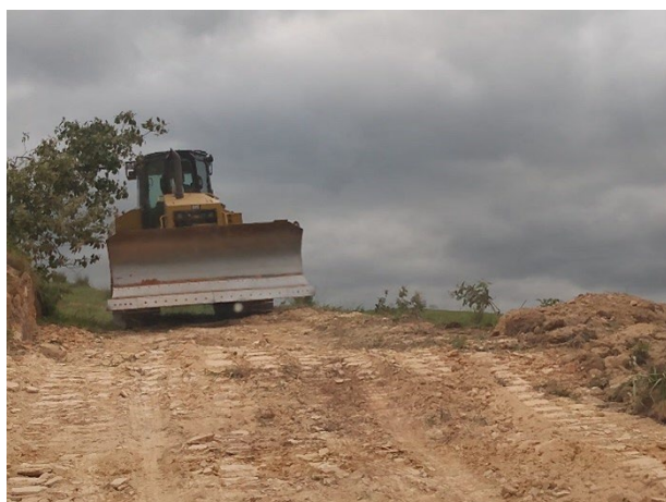
Foto 10: Implantação de Sistema de drenagem. (12/05/2022).
