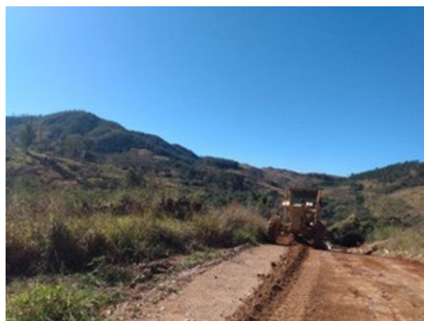
Foto 13: Manutenção no sistema de drenagem provisório no acesso da margem direita (11/08/2022).
