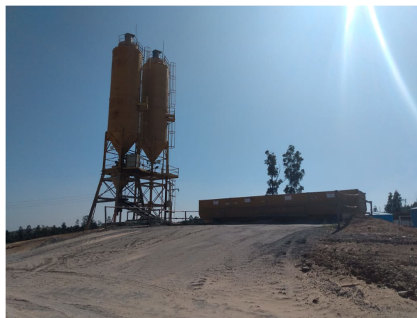
Foto 4: Situação atual das Estruturas no Canteiro operacional (31/08/2022)
