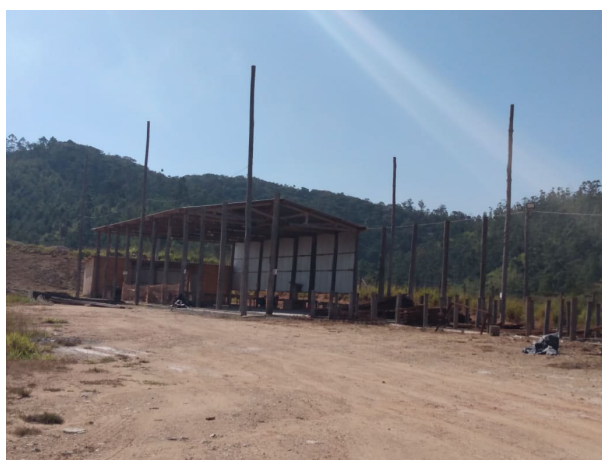
Foto 1: Situação atual das Estruturas no Canteiro operacional (29/07/2022)
