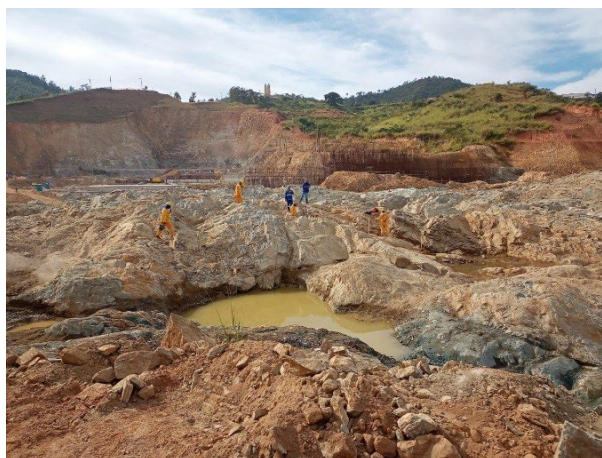
Foto 6: Limpeza rigorosa de topo rochoso das estacas 26+10 (20/05/2022).
