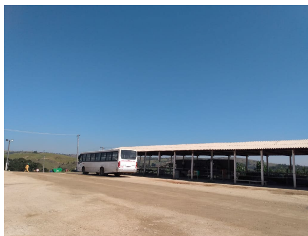
Foto 2: Situação atual das Estruturas no Canteiro operacional (29/07/2022)
