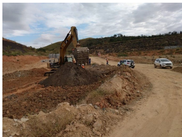
Foto 12 :Manutenção no sistema de drenagem provisório no acesso da margem direita (14/07/2022).
